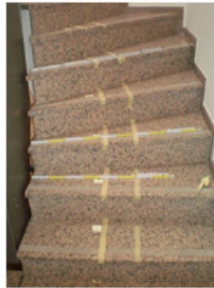
3.6 Treppenaufführung Konstruktionslinie, die den üblichen Weg der Benutzer einer Treppe angibt und im Gehbereich liegt
