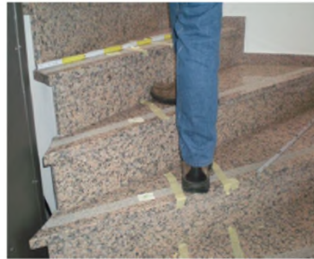
3.6 Treppenaufführung Konstruktionslinie, die den üblichen Weg der Benutzer einer Treppe angibt und im Gehbereich liegt
